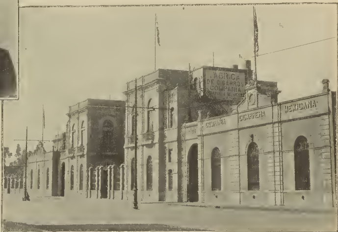
México. - Vista del edificio de la Compañía Cigarrera Mexicana
